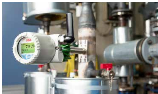
图1. 传感器无处不在。通过能量采集系统供电的低功耗无线传感器节点 (例如这个来自ABB、由采集的热能驱动的无线温度传感器) 可以放置在适当位置, 以获得更多工业环境数据。
